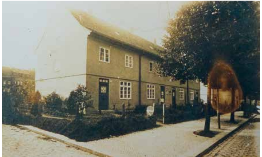
1922 (oder kurz danach) die Häuser (v. r.). Paulsenstraße 46, 46a, 46b, 46c
